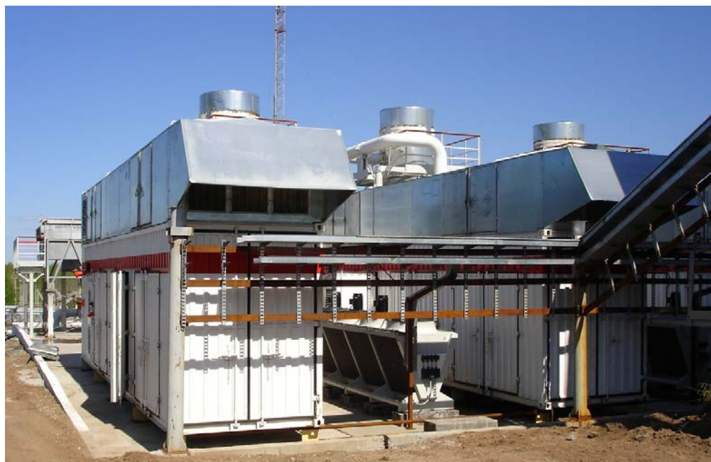
Лукойл УНВА, Русия - Компресор за транспортиране на газ
