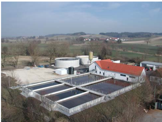
BIOCOS® Пречиствателна станция за отпадъчни води Капацитет 9500 жители (2x4750ж.)
